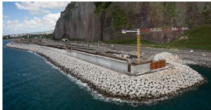
Figure 1 – Une des digues de la NRL
