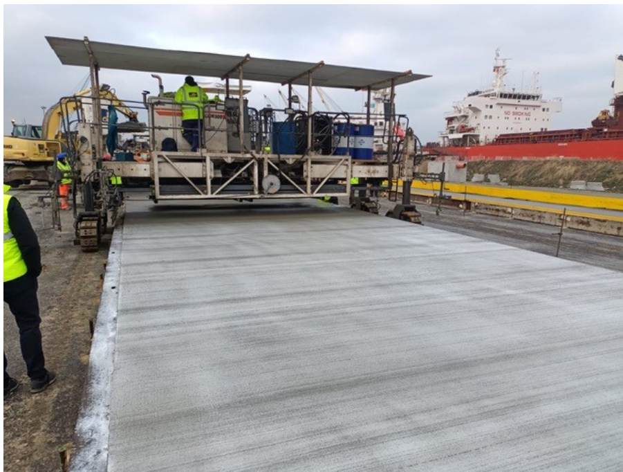
Figure 11 : Détails de l'exécution avec la machine à coffrage glissant
