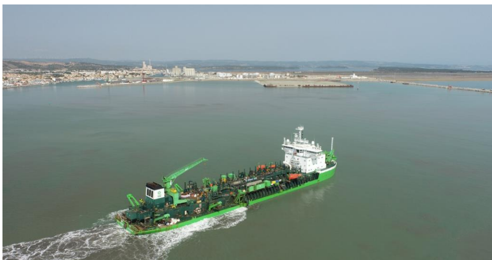
Figure 9 : Juin 2023 – Dragage d'approfondissement de la passe d'entrée du futur bassin portuaire avec le navire NILE RIVER
