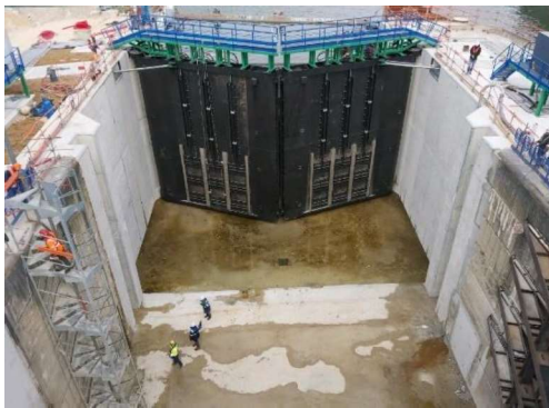
Figure 8 – Nouvelle tête aval de l'écluse n°1 après allongement (source : BRL)
