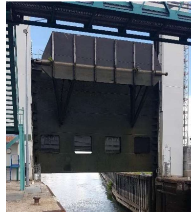
Figure 6 – Porte levante aval de l'écluse n°2 (source : BRL)
