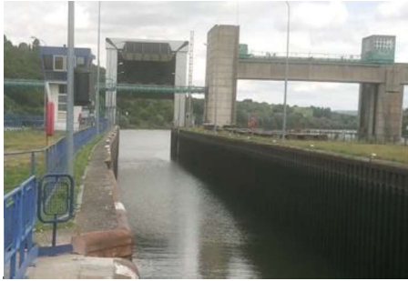
Figure 5 – Déformation du bajoyer gauche de l'écluse n°2 (source : BRL)
