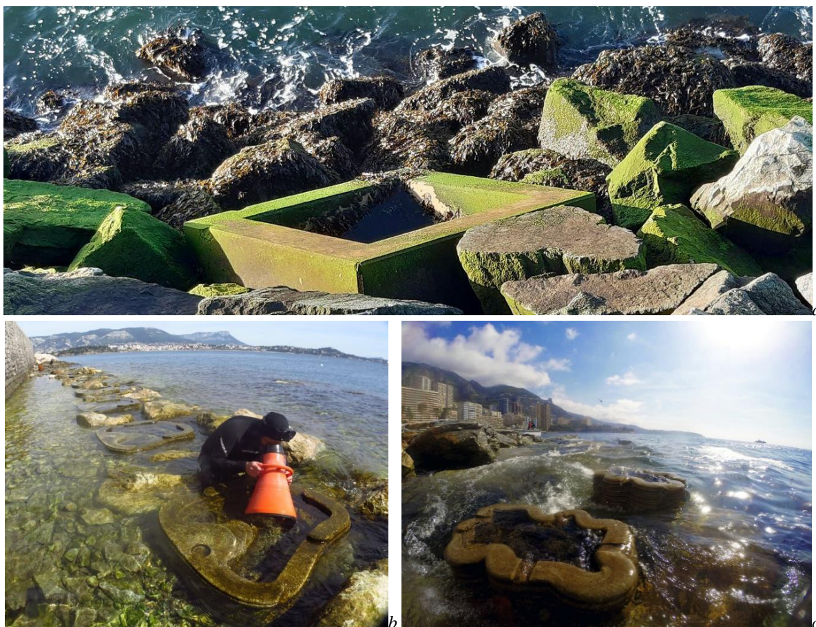
Figure 2 : cuvettes rocheuses artificielles intégrées aux ouvrages (a : Brest ; b : Toulon ; c : Monaco). © SUEZ Consulting.
