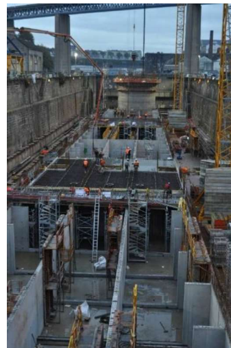
Figure 4 : Préfabrication du ponton
