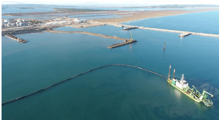
Figure 4 : Novembre 2022 – Construction du merlon d'enclosure, avec protection à l'avancement
