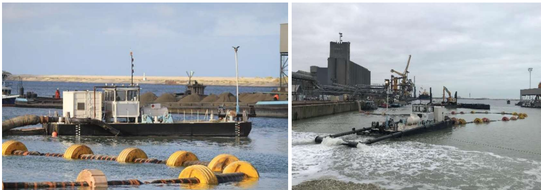
Figure 6 : Mise en œuvre par diffuseur en dessous du niveau de l'eau (A gauche, le bras du diffuseur est sous l'eau, à droite il est au-dessus de l'eau).
